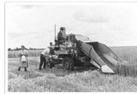
In Hasselhorst mit Claas entwickelter Parzellenmähdrescher. Es blieb beim Prototypen.
